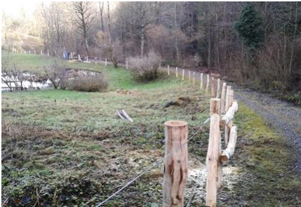
Bau eines Zaunes
